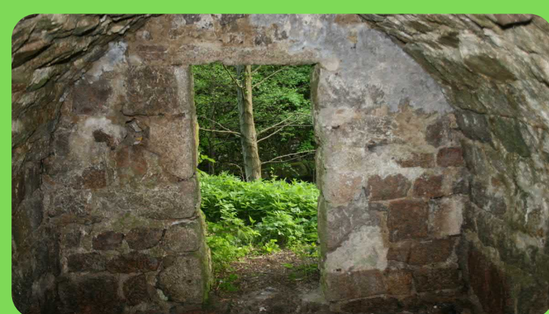
NADZEMNÍ KAMENNÝ SKLEP DOMU Č. P. 193
