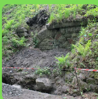
PODCHOD Č. 1 BYL NEJPRVE ZAZDĚN KAMENY A PŘI REKONSTRUKCI TRATĚ R. 2013 BYLA PŘED NÍM VYSTAVĚNÁ ŽULOVÁ ZEĎ KOPÍRUJÍCÍ NÁSEP TRATĚ.
