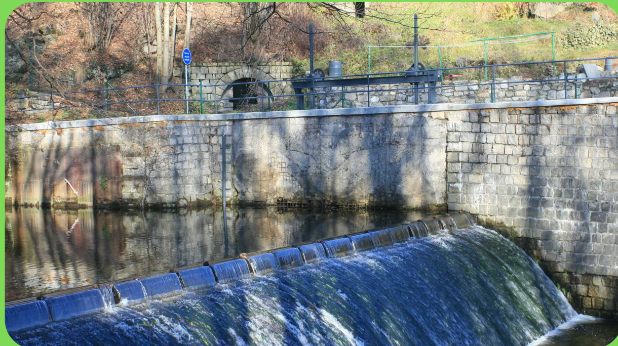
POHLED NA PROTILETECKÝ KRYT Z PROTĚJŠÍHO BŘEHU.
