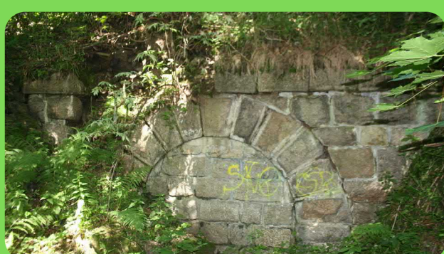
PODCHOD Č. 1 BYL NEJPRVE ZAZDĚN KAMENY A PŘI REKONSTRUKCI TRATĚ R. 2013 BYLA PŘED NÍM VYSTAVĚNÁ ŽULOVÁ ZEĎ KOPÍRUJÍCÍ NÁSEP TRATĚ.
