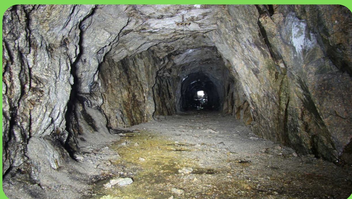
CHODBA JE PŮLKRUHOVÉHO PRŮŘEZU VÝŠKY PRŮMĚRNĚ 2,3 M A ŠÍŘE PRŮMĚRNĚ 2,5 M S DÉLKOU PŘÍMÉ CHODBY CCA 63 M A BOČNÍ CHODBY CCA 62,7 M.
