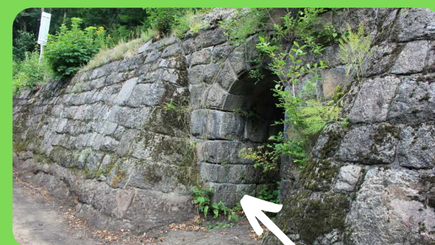
PODCHOD Č. 3 S VYTESANÝM DATUM PŮVODNĚ R. 1897
