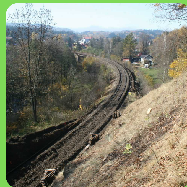
NA PODZIM 2012 PROBĚHLA VÝMĚNA KOLEJÍ V OBLASTI ZA VODOU, DŘEVĚNÉ PRAŽCE BYLY NAHRAZENY.
