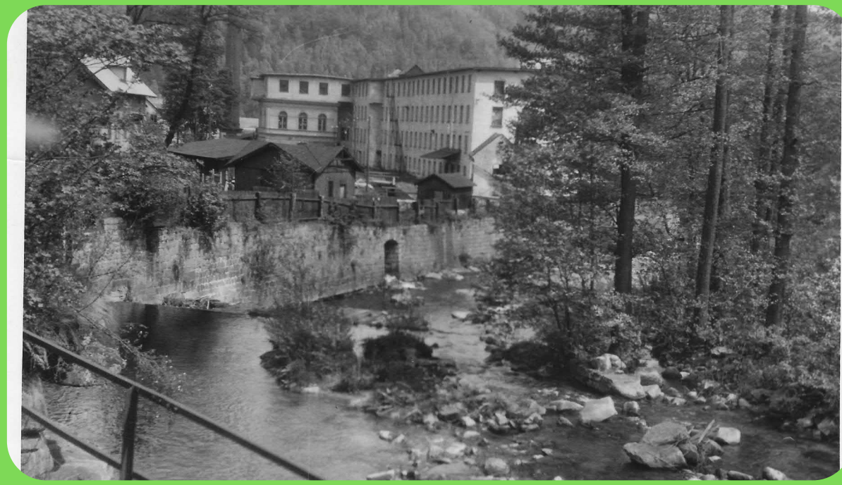
PŮVODNÍ NÁHON S BUDOVOU TKALCOVNY
