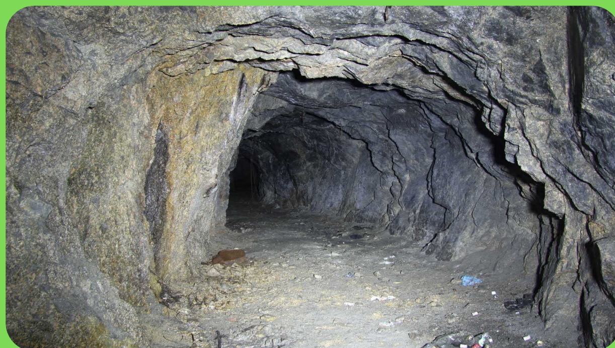
DO TÉTO ČÁSTI KRYTU BYL PŘIVEDEN EL. PROUD A ZHOOTOVENO OSVĚTLENÍ.
