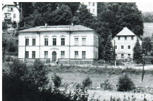
Budova č.p. 43 vpravo, první pošt. úřad v Horním Tanvaldě
